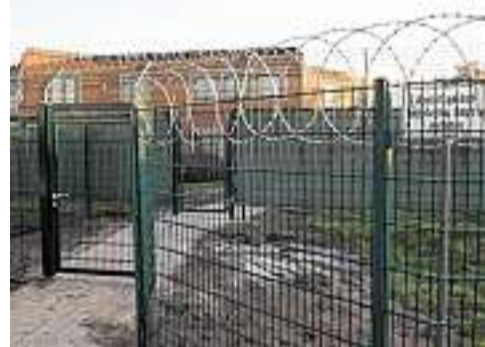
In diesem Gebäude bei der JVA sollen Jugendliche untergebracht werden. FOTO: KUHAUPT
