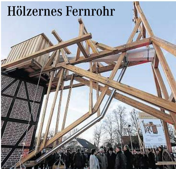
Die Rekonstruktion eines historischen Teleskops ist in Lilienthal eröffnet worden. Es besteht aus einem mehr als sieben Meter hohen Fachwerkturm mit einem drehbaren Aufbau. Das hölzerne
