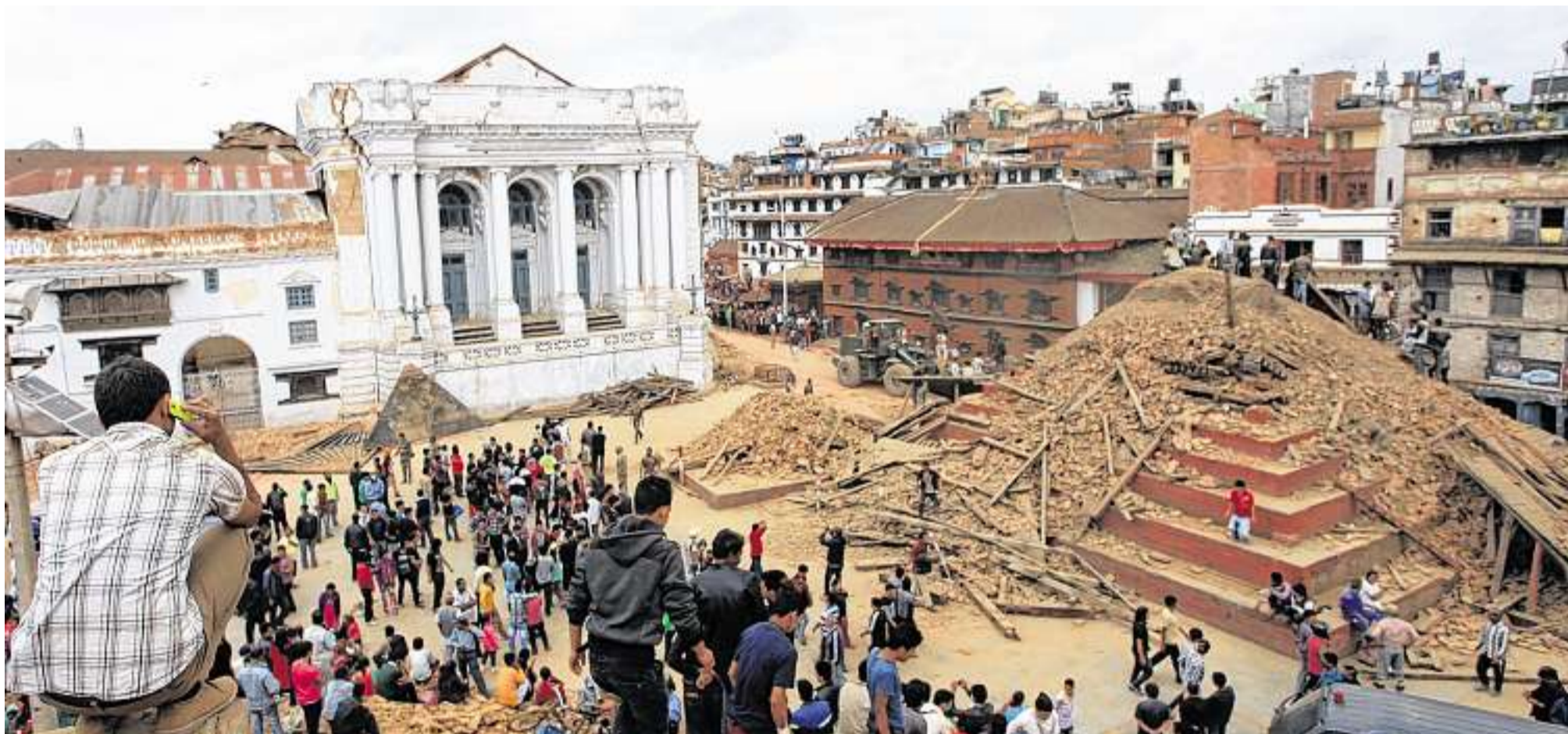
Zahlreiche Gebäude wurden in der nepalesischen Hauptstadt Kathmandu durch das Erdbeben komplett zerstört.
